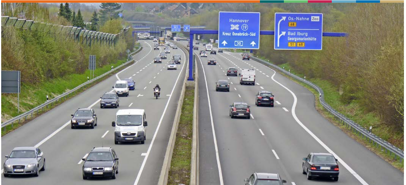
Abb. 1: Autobahn A 30 in Osnabrück (Quelle: Niedersächsische Landesbehörde für Straßenbau und Verkehr)
